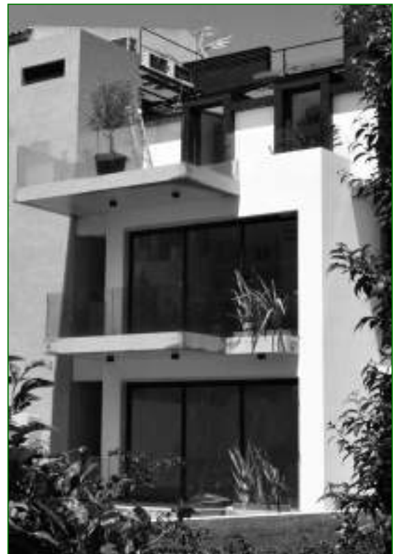
Figura 15 O mesmo edifício depois de 2015 – tardoz. Fotografia da autora.
