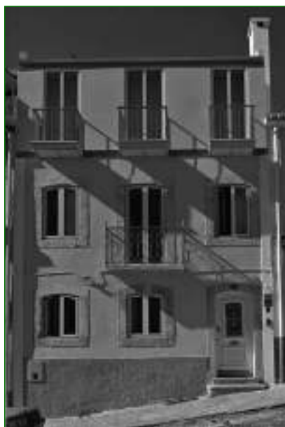
Figura 17 Esventramento e reconstrução na Rua das Trinas, 2016. Fotografia da autora.
