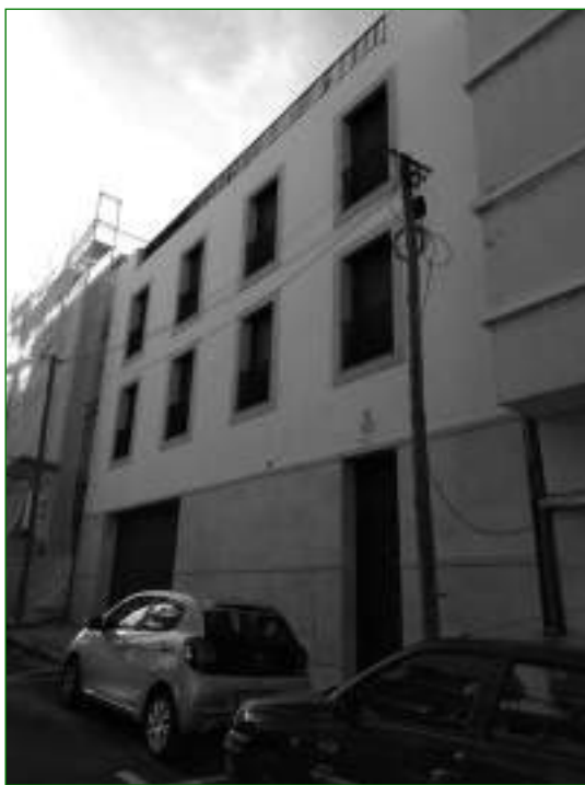
Figura 6 O edifício que substituiu o preexistente em 2019. Fotografia da autora.
