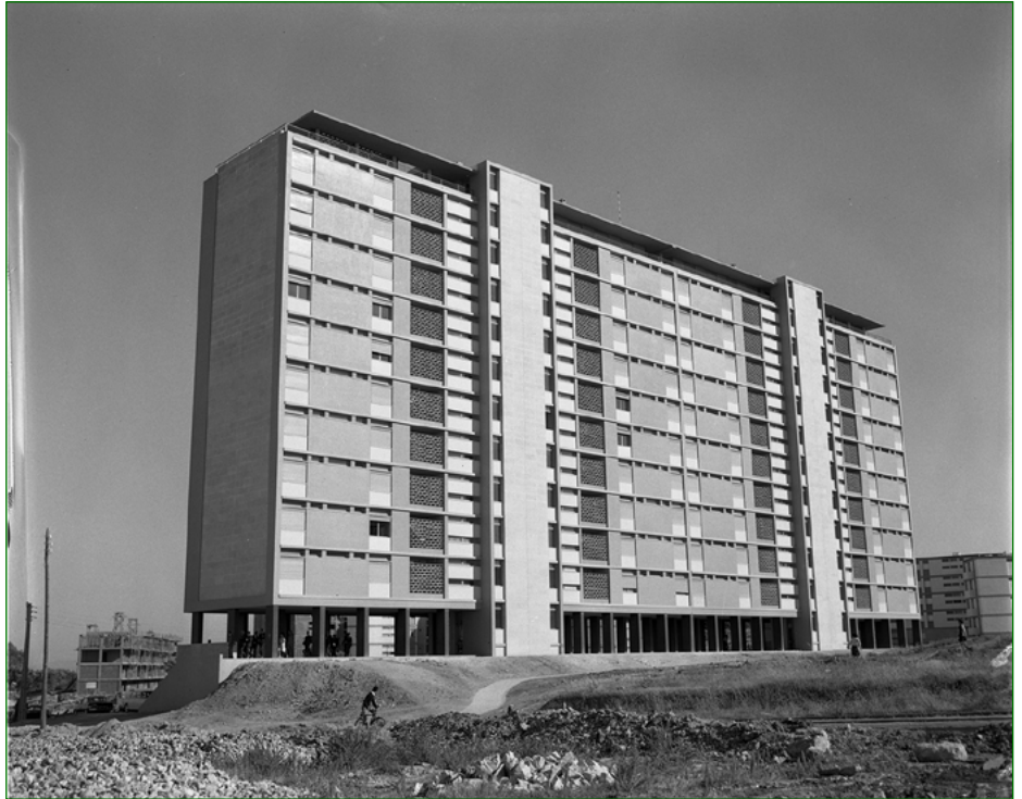
Figura 3 Edifício de Abel Manta em Olivais Norte, fotografia de Armando Maia Serôdio, 1963. AML, PT/AMLSB/CMLSBAH/PCSP/004/SER/005332.
