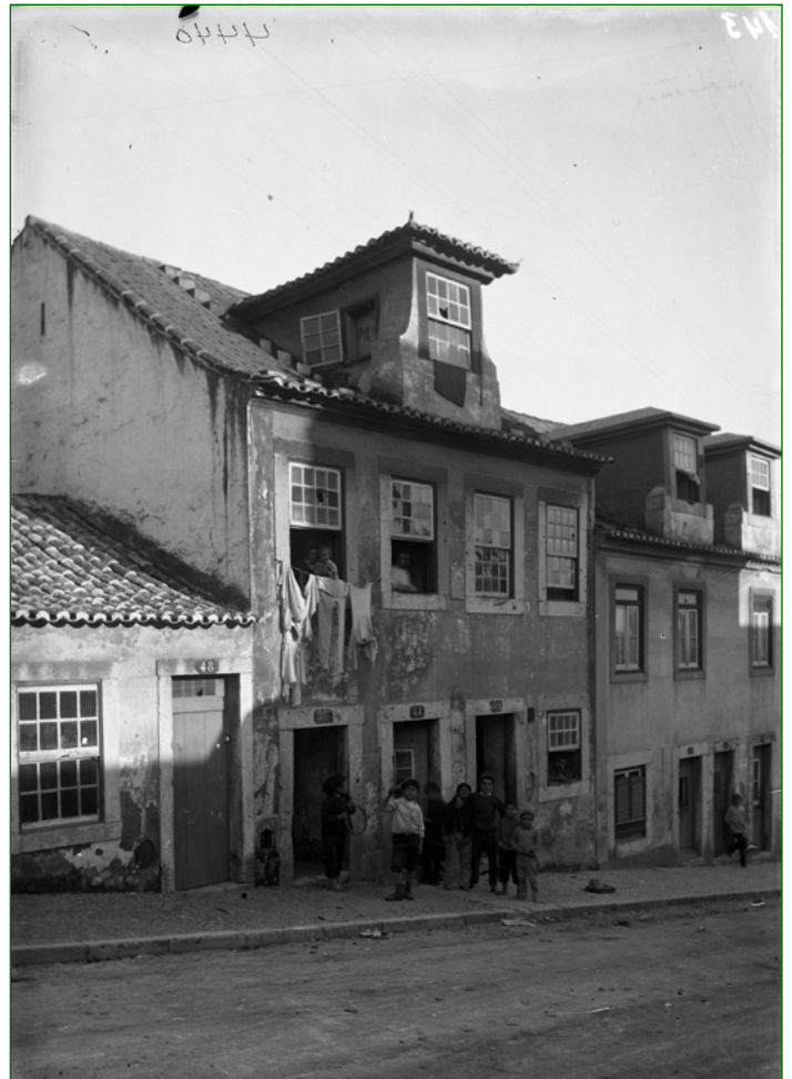
Figura 7 Rua de São Felix, 18 a 22 (antigos talhões 288, 289 e 290) Machado & Souza, 1898-1908. AML, PT/AMLSB/CMLSBAH/PCSP/003/FAN/000143.
