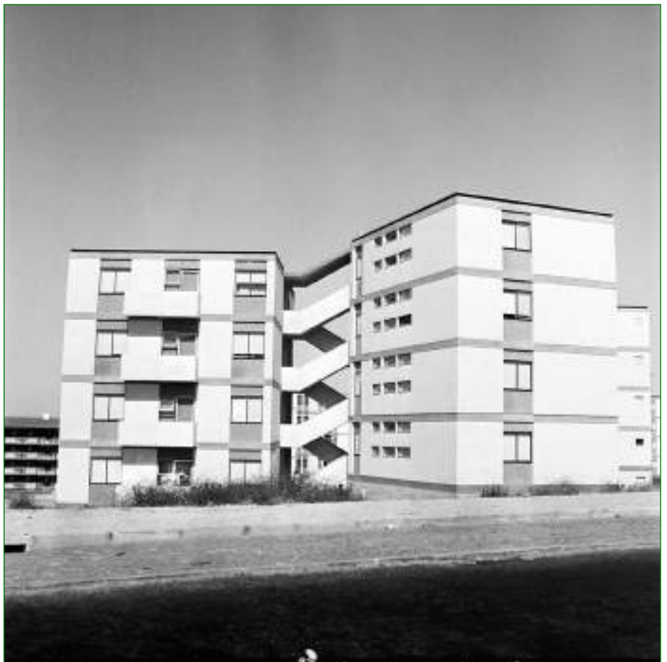
Figura 4 Edifício de Vasconcelos Esteves, fotografia de Artur João Goulart, 1965. AML, PT/AMLSB/CMLSBAH/PCSP/004/AJG/S02419.
