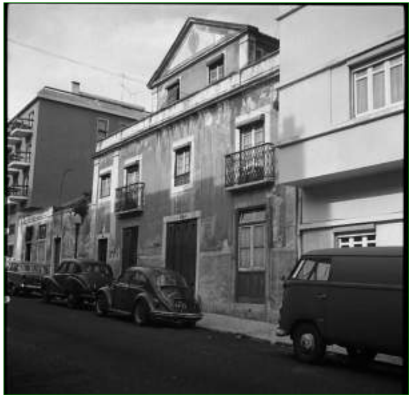
Figura 3 O mesmo edifício em 1969. Arquivo Municipal de Lisboa, PT/AMLSB/CMLSBAH/PCSP/004/JHG/004107
