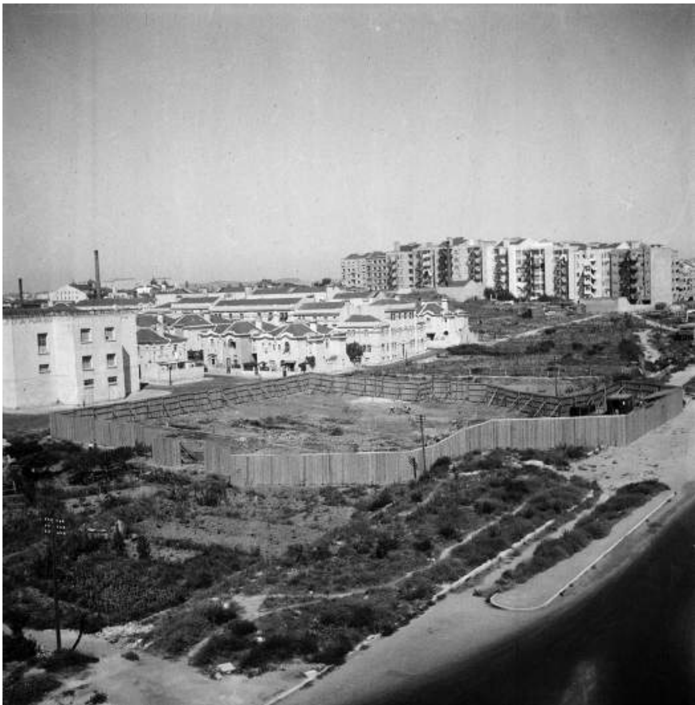
Local destinado à construção da igreja de São João de Deus com o Bairro Social do Arco do Cego em fundo, negativo de gelatina e prata em nitrato de celulose, Judah Benoiel, 6 x 6 cm, ant. 1953. Arquivo Municipal de Lisboa, PT/AMLSB/CMLSB/PCSP/004/JBN/004571.
